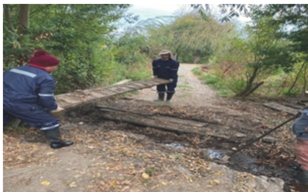
MEJORAMIENTO PUENTE DE MADERA
