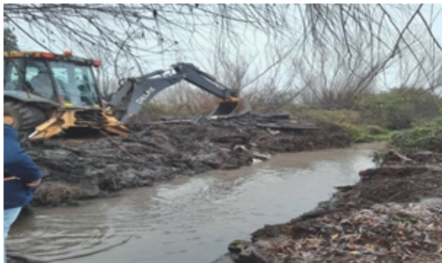
CONSTRUCCIÓN ALCANTARILLA SECTOR LILAHUE
