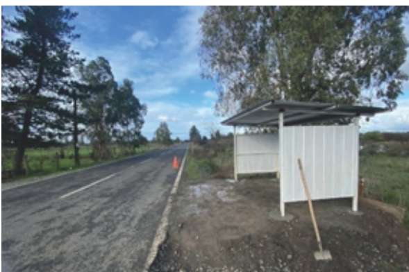
CONSTRUCCIÓN REFUGIOS PEATONALES
