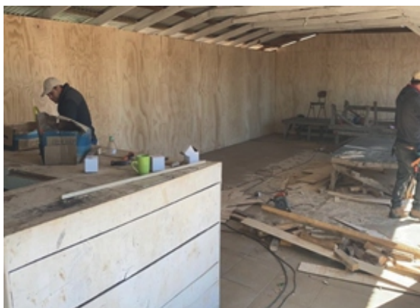
REVESTIMIENTO INTERIOR COMEDOR SEDE JJVV LUCUMAVIDA NORTE
