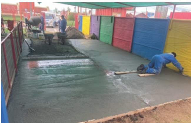
HABILITACIÓN PATIO INFANTIL SALA CUNA LOS ENANITOS
