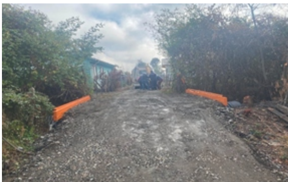
ALCANTARILLAS MONTE ATRAVESADO
